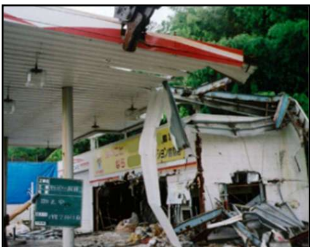
・キャノピー解体(撤去中)
