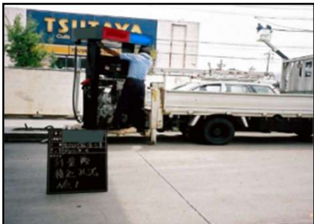
・計量機撤去中
