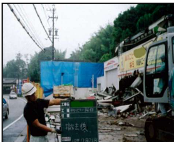
・キャノピー解体(撤去後)
