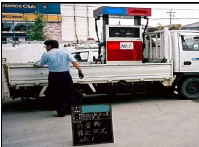
・計量機積み込み
