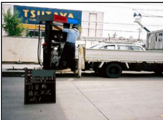
・計量機撤去中
