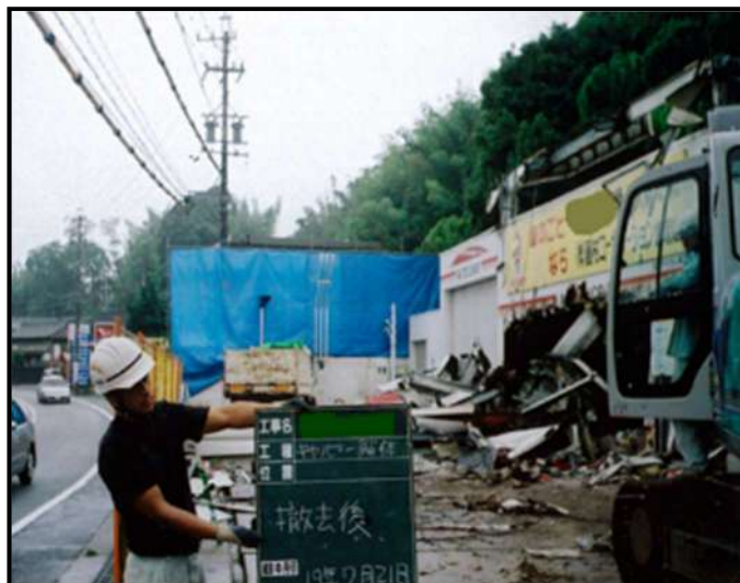
・キャノピー解体(撤去後)
