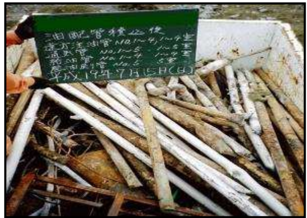
* 運搬車両に配管を積込した写真
