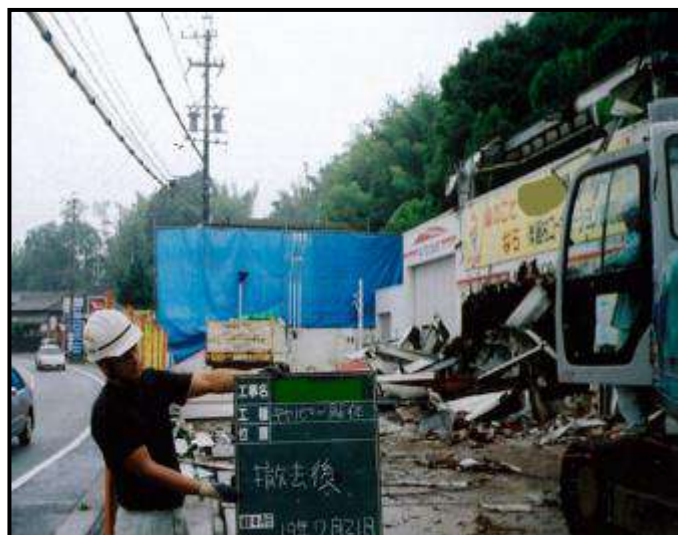
・キャノピー解体(撤去後)
