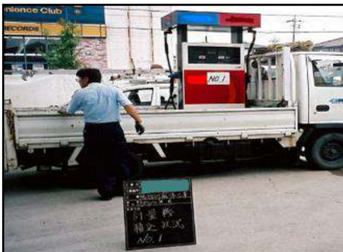
・計量機積み込み
