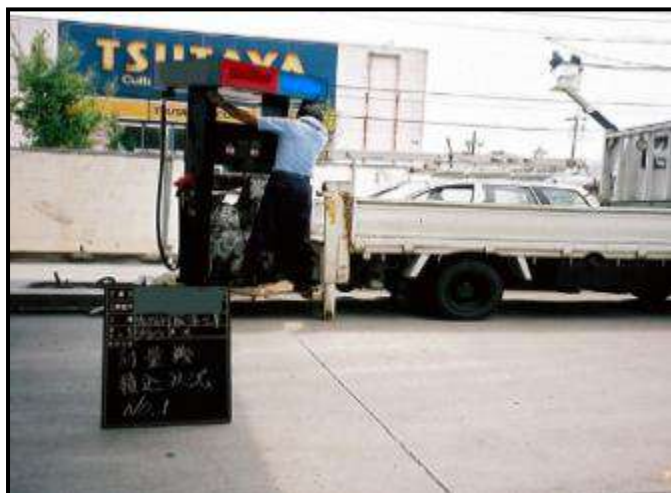
・計量機撤去中
