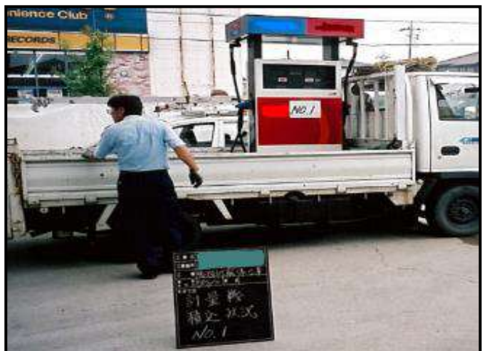
・計量機積み込み
