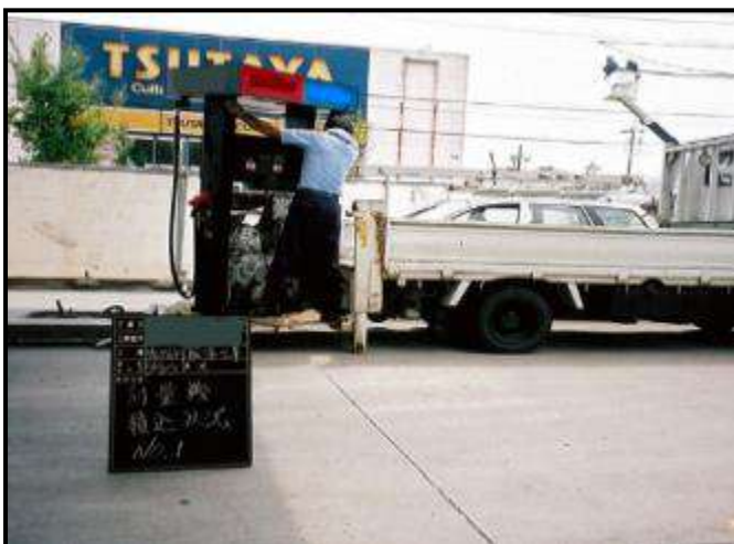
・計量機撤去中
