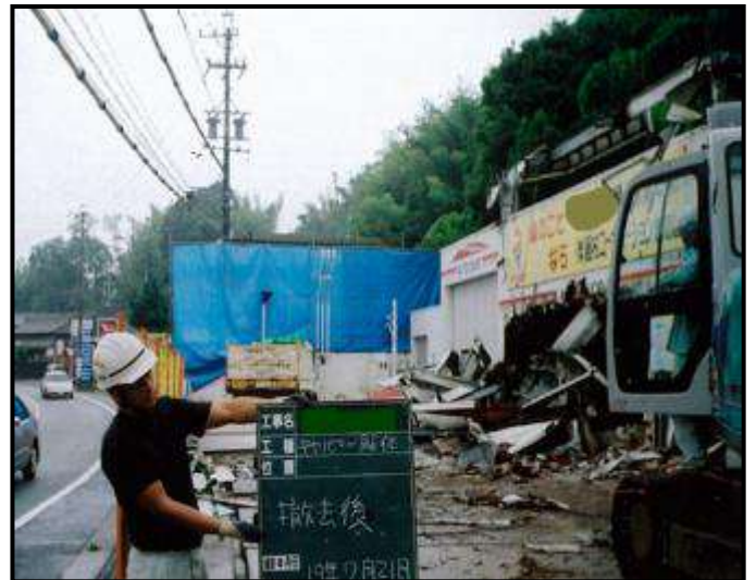
・キャノピー解体(撤去後)
