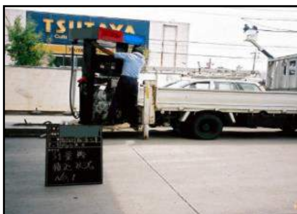
・計量機撤去中
