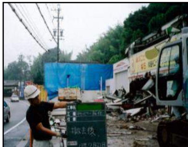
・キャノピー解体(撤去後)
