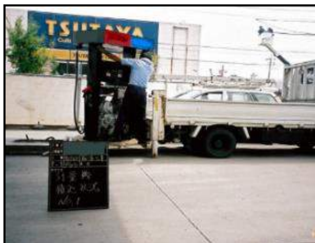
・計量機撤去中
