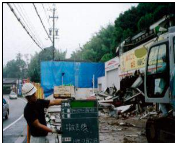
・キャンピー解体(撤去後)
