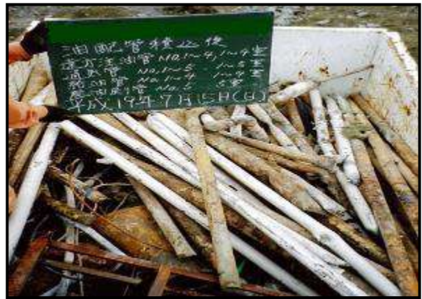
* 運搬車両に配管を積込した写真
