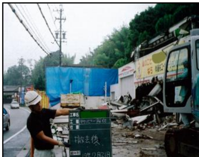
・キャノピー解体(撤去後)
