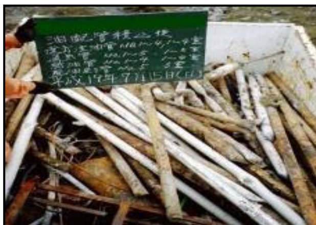
* 車両に配管を積込した写真は必要
