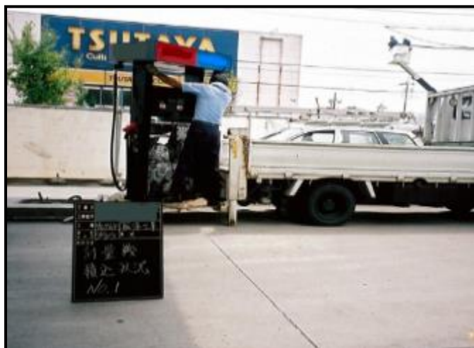
・計量機撤去中
